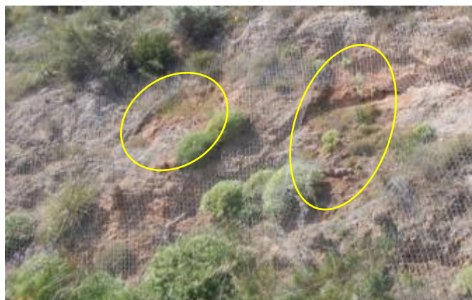
Figura 5-2 – SS187 Tratto 1 Stratificazione sub-orizzontale nei calcari lungo la parete sovrastante il pendio.
