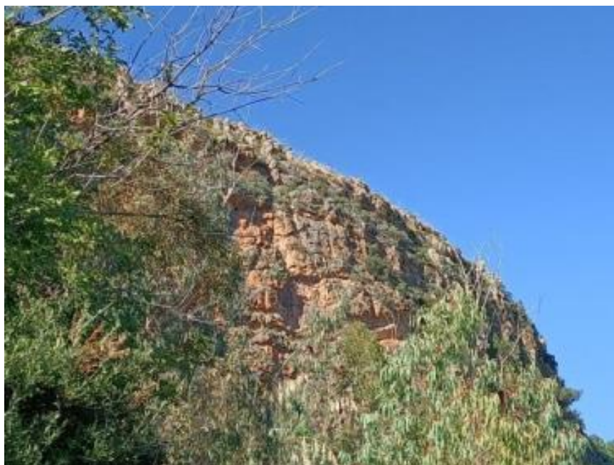
Figura 4.2 - Fm. Sciacca affiorante lungo il versante a monte delle barriere paramassi
