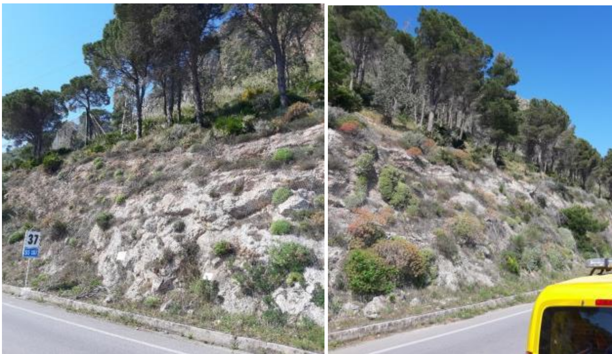
Figura 5-1 – Panoramica del Tratto 1: SS187 dal km 36+900 al km 37+050 direzione Palermo.
