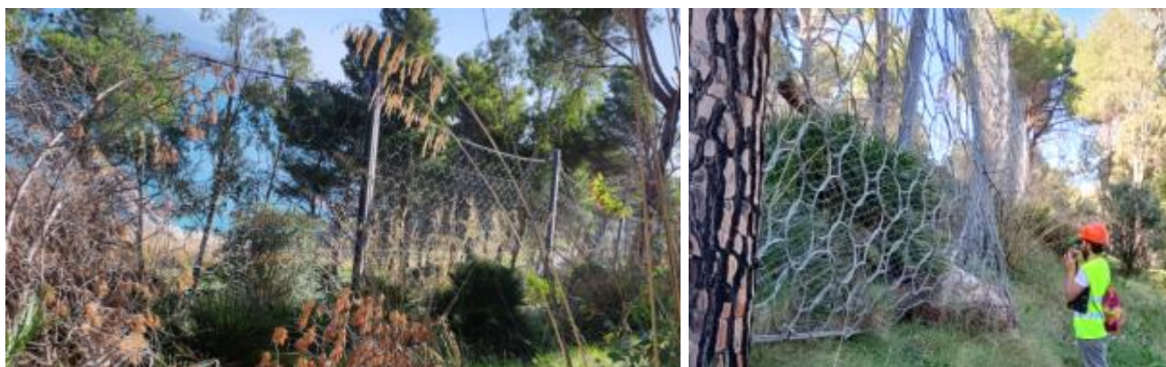
Figura 5-3 – SS187 Tratto 1 Tratto di barriera già installato ed immagine di un blocco trattenuto dalla struttura.
